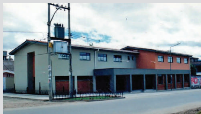
Término de la construcción de la Sede principal.
