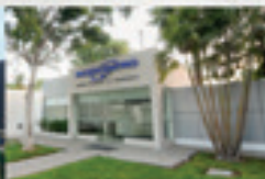
Piura Av. San Ramón 549
